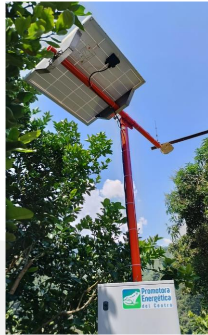
Estación de transmisión de datos vía Celular, a página web Aquatic.com.co
