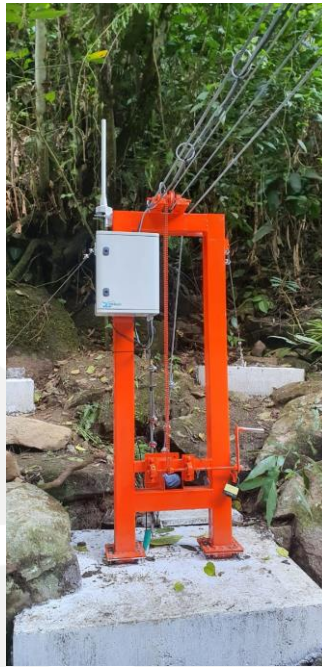
Torre Orilla derecha, gabinete y estación de radio para transmisión de datos
